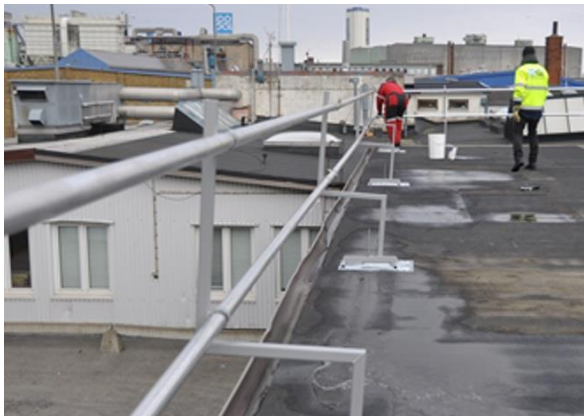
Figur 23 a-b. Skyddsräcken på låglutande tak (< 6 gr), ICOPAL, infäst i Welands infästningsplåt. Infästningsplåten skruvas ner i undertaket och täcks över vid läggning av tätskikt. Lämnas kvar för framtida bruk. Observera fotlist saknas. Hållare finns dock.
