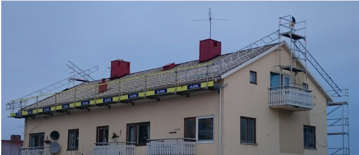
Figur 20. Hängande ställning och skyddsräcke vid gavel. Observera fotlist saknas vid gavelräcke.
